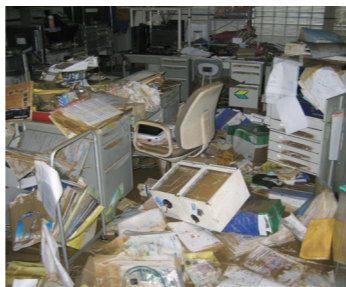
▲手の位置まで浸かった自家発電機と浸水した社屋1階
